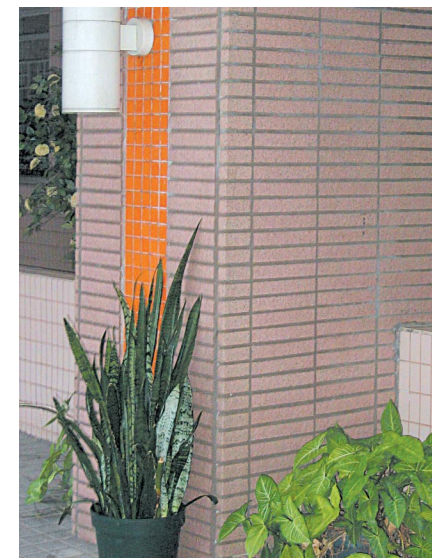
3.1.1d) 突出的照明灯饰阻碍通道，补救措施是在其下放置盆栽
