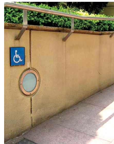
4.1.2.3d) 斜道的地脚灯
