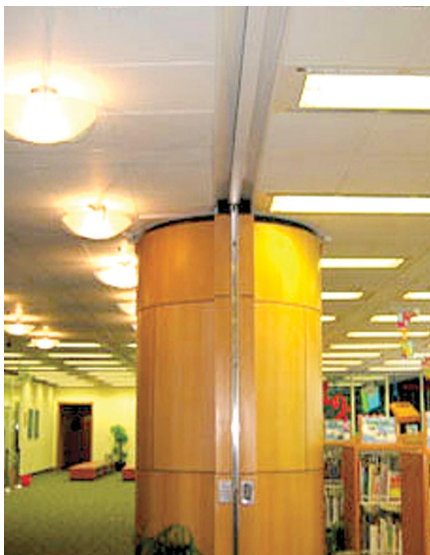
4.1.2.3d) 典型楼层的各种照明装置
