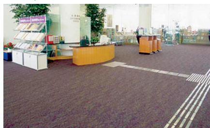
4.1.2.3a) 前往柜台的通道铺设触觉引路径
