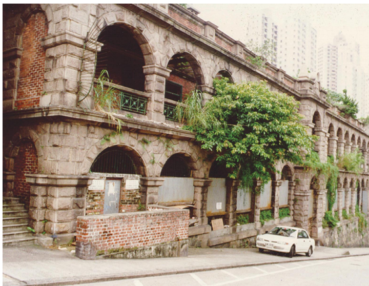
6.1.2a) 保存古老建筑物的外貌
