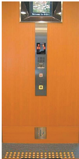
6.6.1a) 良好设计的升降机等候间 一两个不同高度的升降机按钮和发声及视像讯号
