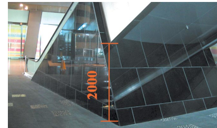
6.7.2f) 遮隔自动电梯的底部
