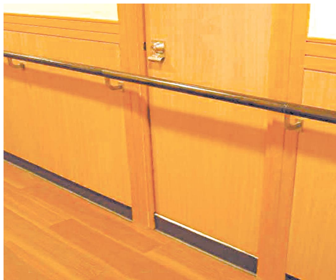
6.5.3b) 沿走廊的连续扶手
