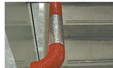
6.7.1i) 扶手末端转向墙壁
