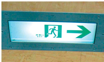
6.8.5a) 显示出口方向的指示牌
