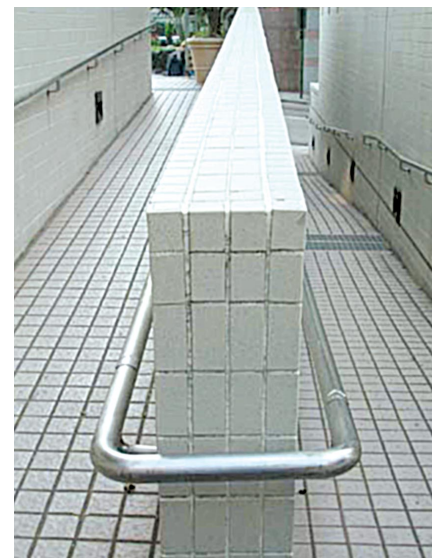
6.2.3c) 斜道上凹入墙身的照明装置，扶手上铺有凸字，提供方向指示
