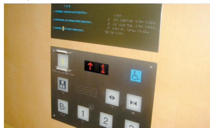
6.6.1c) 延长升降机门开启时间的控制按钮
