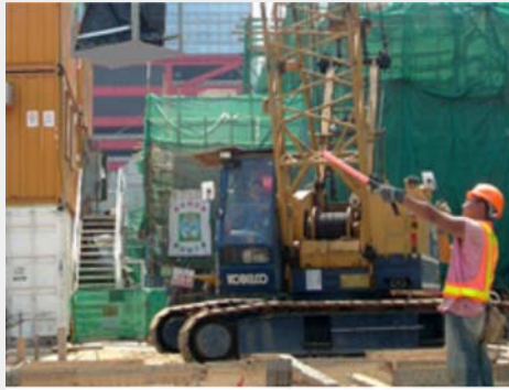
起重作业的有效沟通
