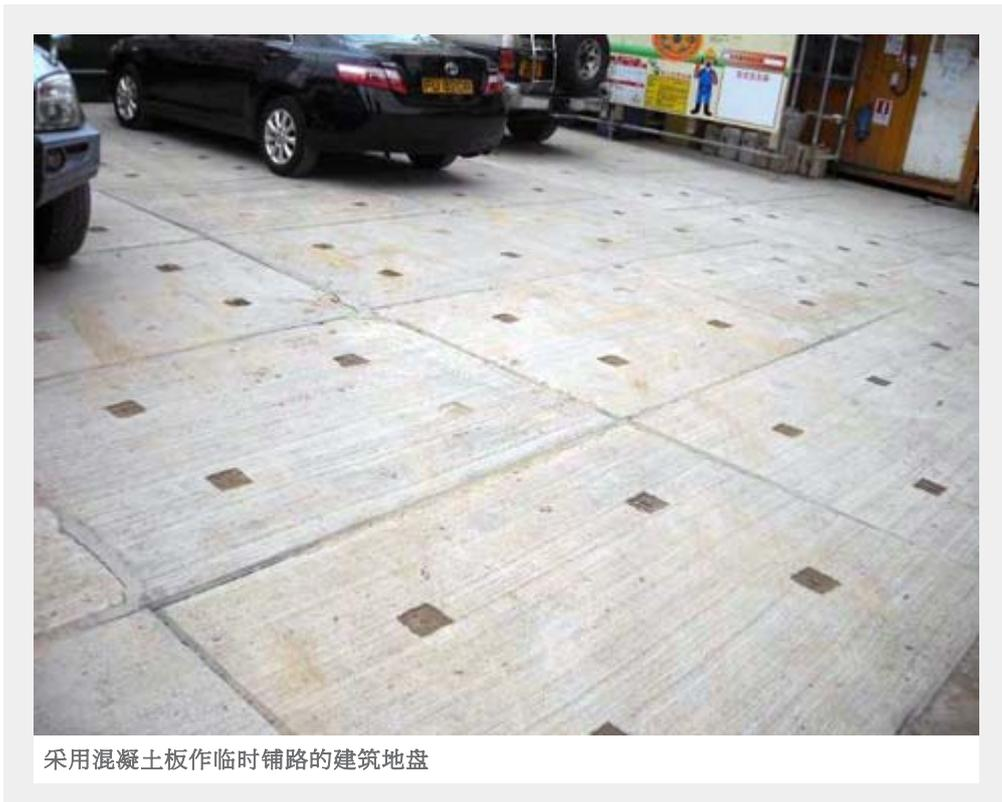
采用混凝土板作临时铺路的建筑地盘
