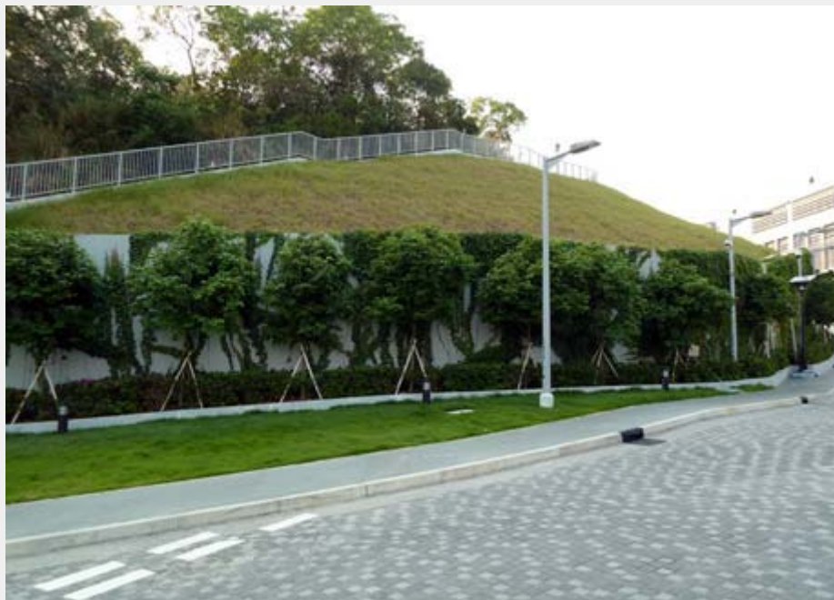
護土牆採用垂直綠化
