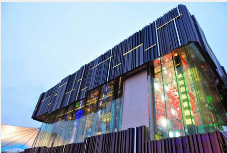
南面外牆的景觀水簾
