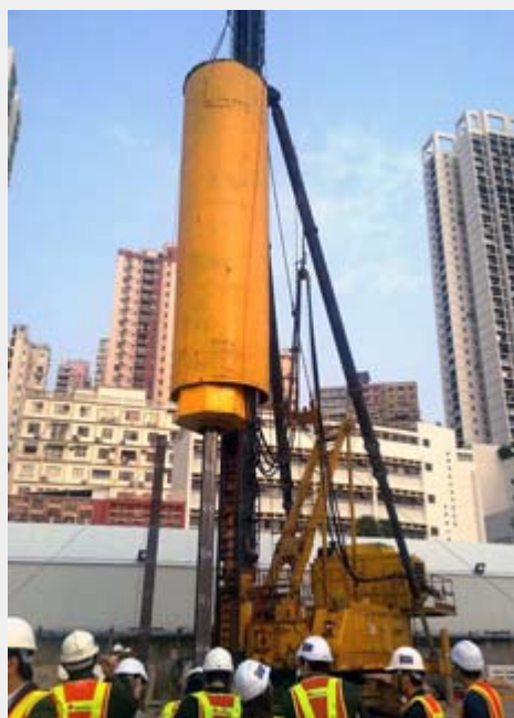
打樁機隔音罩
