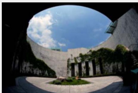
鑽石山火葬場重置工程 — 優質建築大獎 2010 — 優異獎 (香港非住宅類別)
