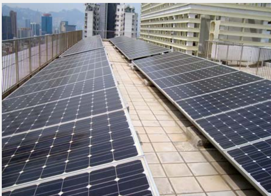
屋頂裝設太陽能光伏板供電
