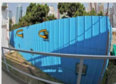
樹木圍板開孔改善空氣流通
