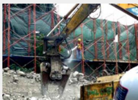
使用液壓碎石機
