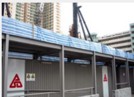
用防水布防止濺出泥水
