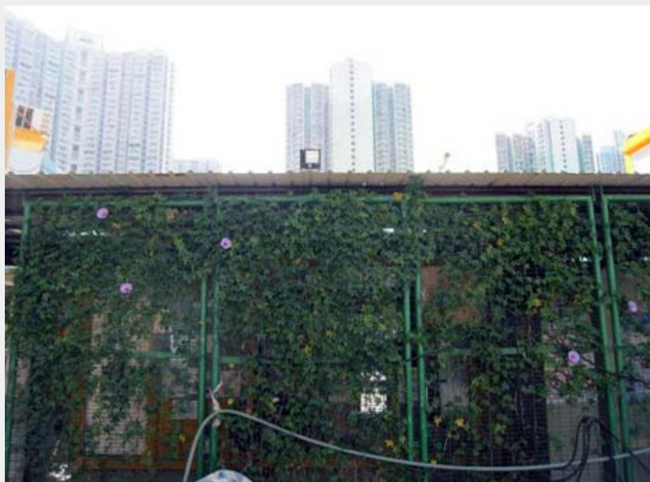
工地走廊設綠化屏
