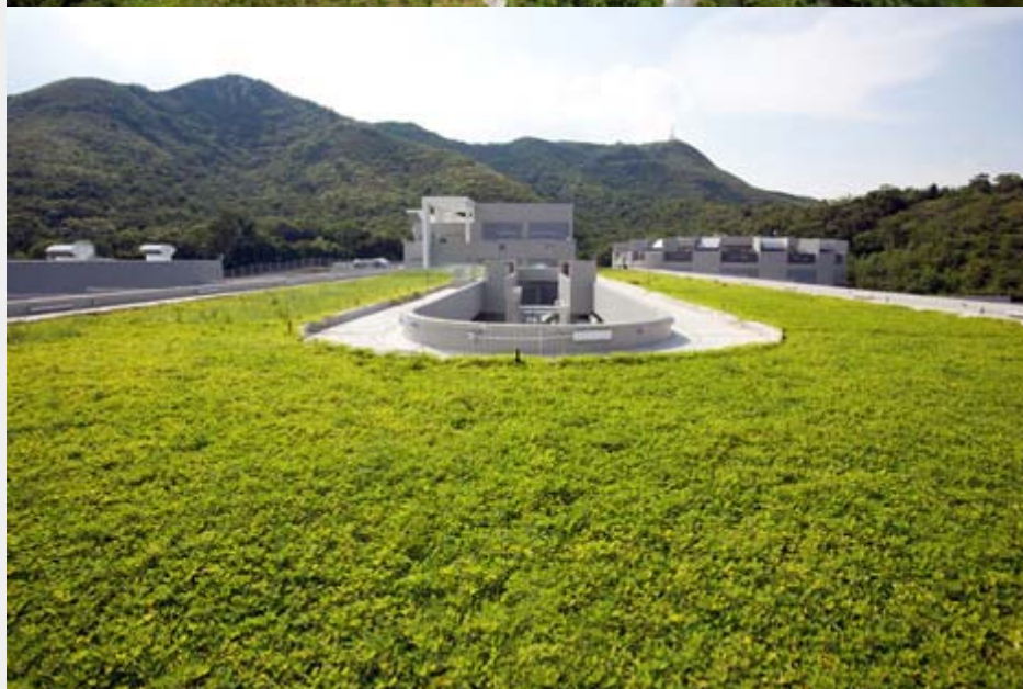
重建羅湖懲教所 - 環保建築大獎2010 - 社區設施大獎 (新建建築類別 - 香港)
