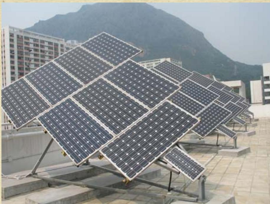
装有太阳追踪器的太阳能光伏板
