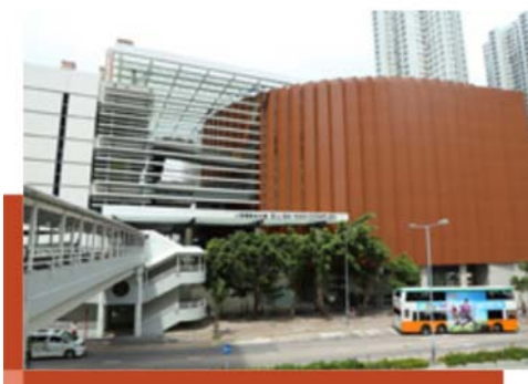
小西湾综合大楼
