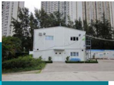
工地办事处的建筑元件采用螺栓螺母组合，方便日后拆卸再用
