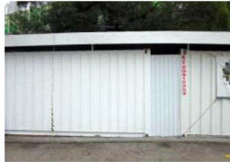
办公室装设金属天台及气隙改善通风
