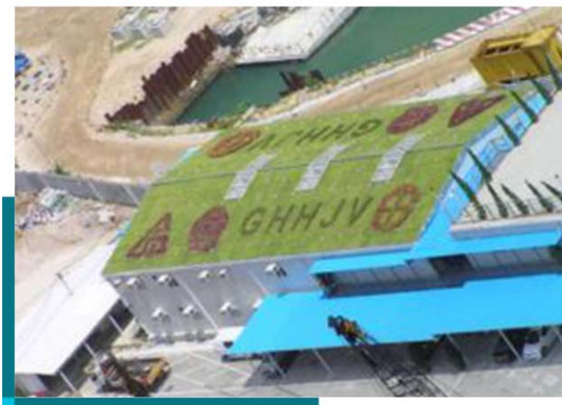
工地办事处的绿化天台
