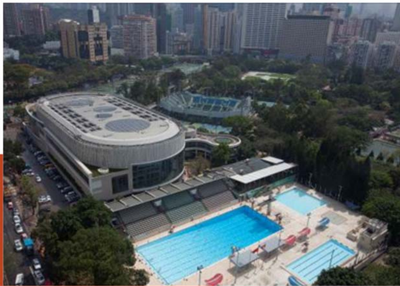
维多利亚公园游泳池重建项目
