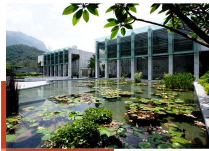
钻石山火葬场重置工程项目
