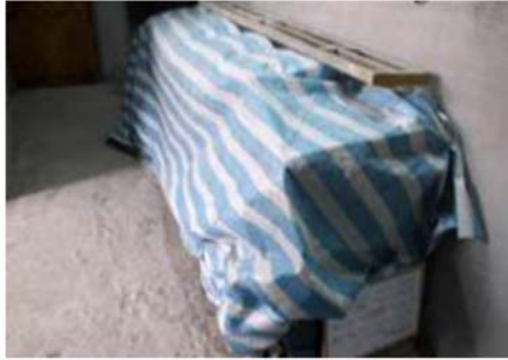
铺盖灌浆台及堆存的水泥
