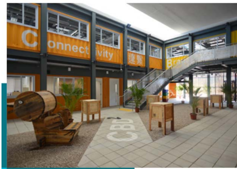
在观塘绕道下的庭院使用自然通风及反射自然光照明
