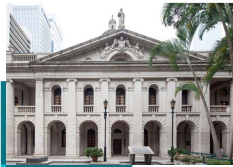
大楼外部将进行维修及复修工程
