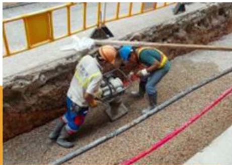
压实外露土层表面
