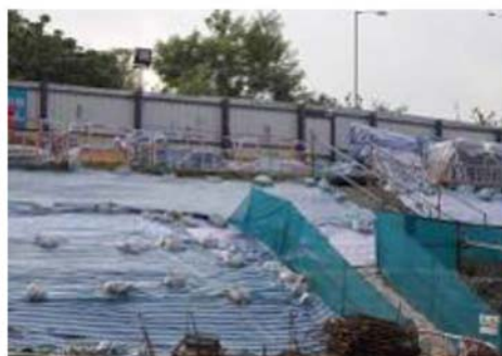
封蓋外露土坡
