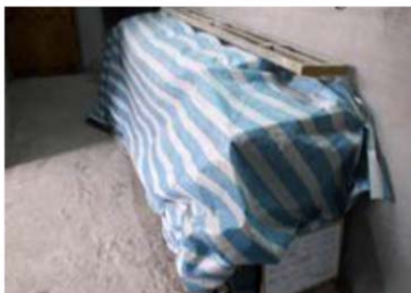
鋪蓋灌漿台及堆存的水泥
