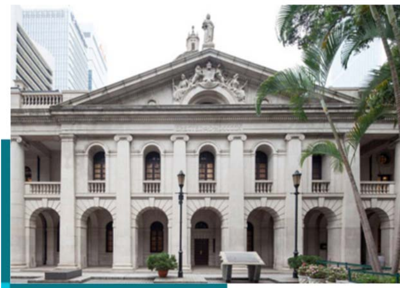
大樓外部將進行維修及復修工程
