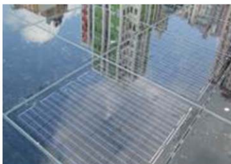
附設於建築物光伏系統的光伏板
