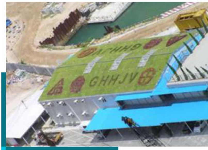
工地辦事處的綠化天台
