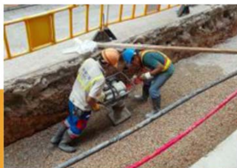
壓實外露土層表面
