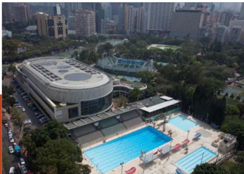
維多利亞公園游泳池重建項目
