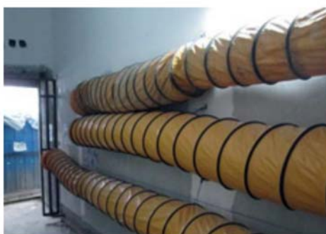
密封通風氣槽系統，防止塵埃及 污染物積聚
