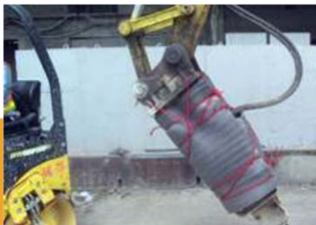
油壓破碎機裝上吸音套
