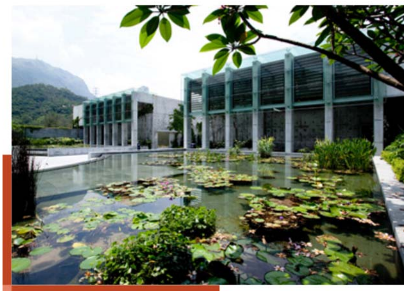
鑽石山火葬場重置工程項目
