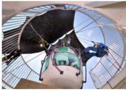
缆车救援训练设施
