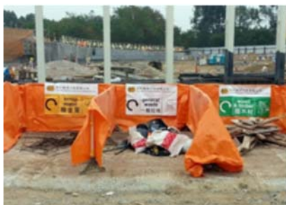
划定工地废物分类专区
