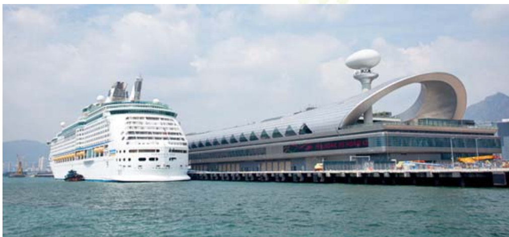
邮轮码头大楼外貌
