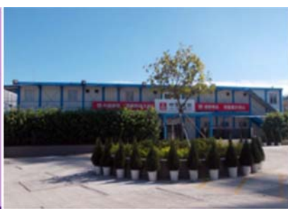
工地绿化及铺砌硬路面
