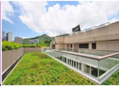
绿化屋顶装置
