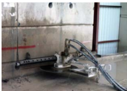
使用低塵量鋸切方法進行拆卸工程
