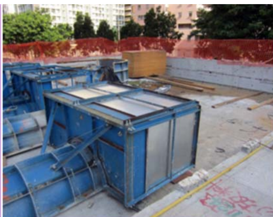
利用特製隔音板阻隔澆置混凝土柱時發出的嘈吵噪音
