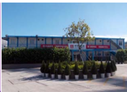
工地綠化及鋪砌硬路面
