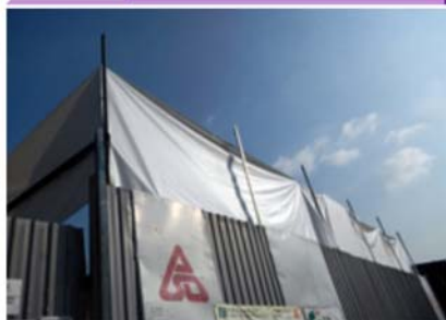
架設隔塵板
