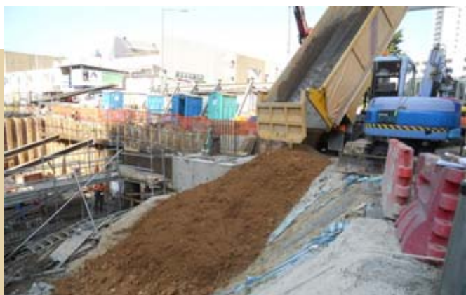
利用在工地挖掘的物料作回填料 2
