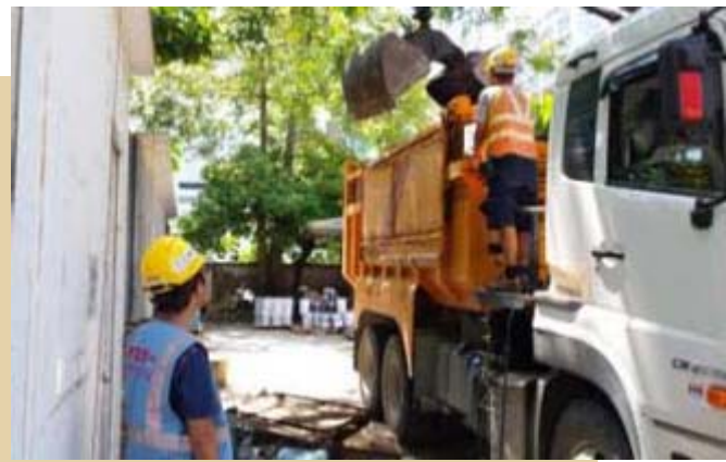
监督建造及拆卸工程物料的输送过程 4
