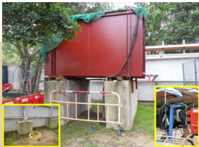
循环再用脱水井的地下水喷淋树木 2
