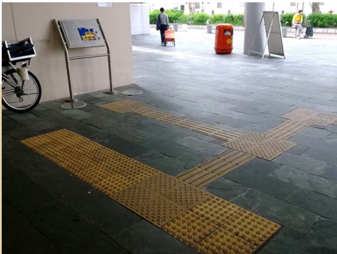
已完竣的无障碍出入设施改善工程
