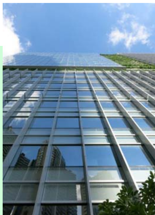
纵向遮档太阳装置(左)近距特写及外墙不同位置安装遮档太阳装置(右)减少热增量及眩光
