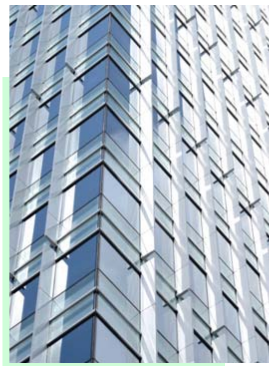
纵向遮档太阳装置(左)近距特写及外墙不同位置安装遮档太阳装置(右)减少热增量及眩光
