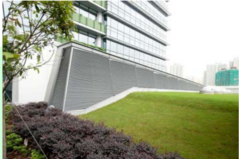
社区会堂走廊的太阳能烟囱系统
