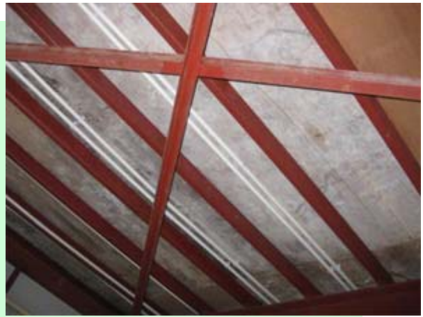
以回收再用结构钢材建造工地办事处的框架
