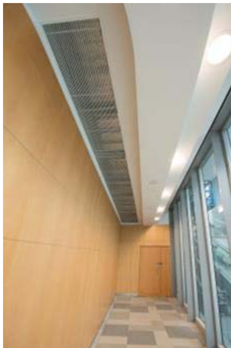
地库停车场的太阳能烟囱系统
