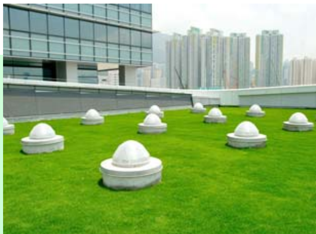
日光导管在社区会堂天台采集阳光(左)，透过高反光度的内层(右)将光线传到多用途练习场
