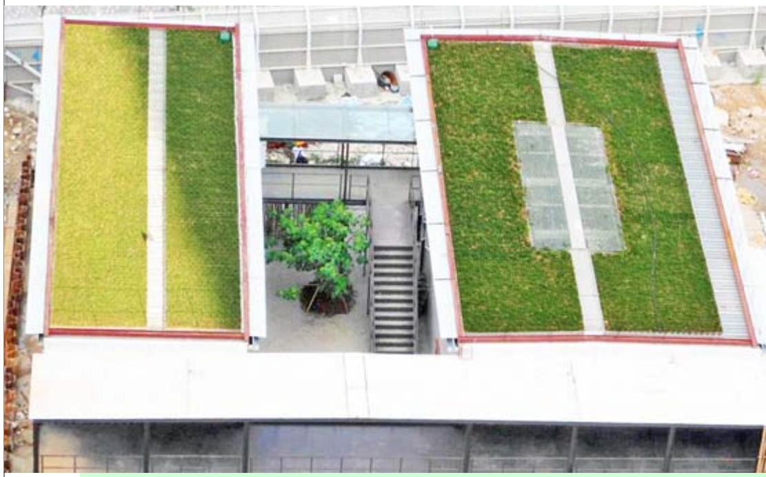
启晴村学校建筑工地办事处外观
