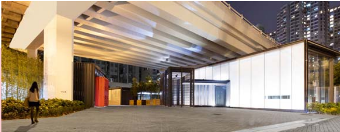
東區社區環保站
