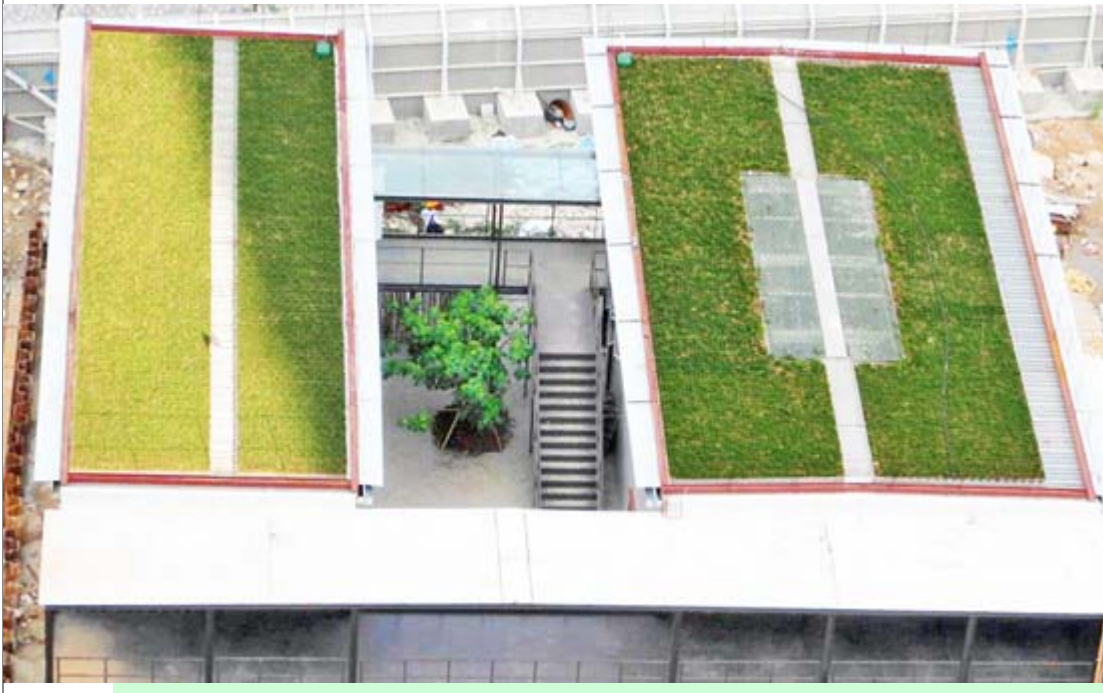
啟晴邨學校建築工地辦事處外觀
