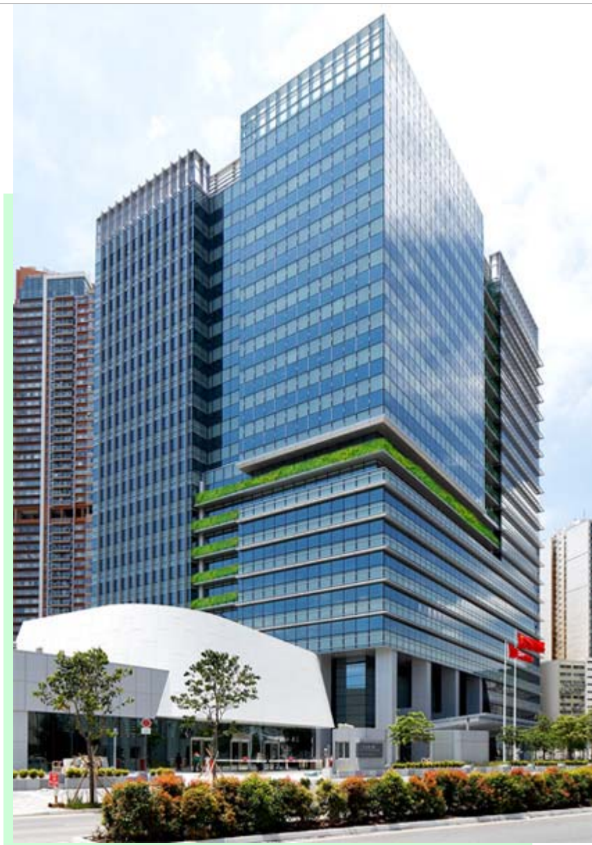
工貿大樓協調道一側外貌
