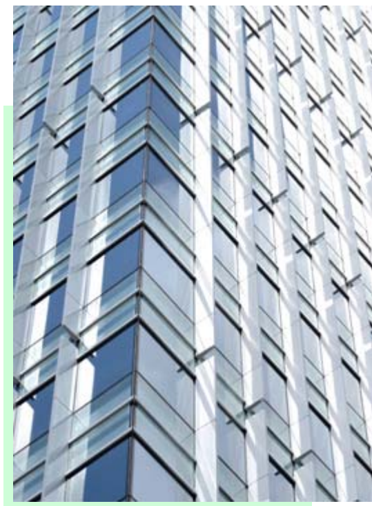
縱向遮檔太陽裝置(左)近距特寫及外牆不同位置安裝遮檔太陽裝置(右)減少熱增量及眩光
