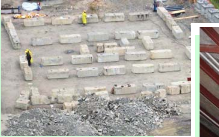
用混凝土磚建造工地辦事處基腳
