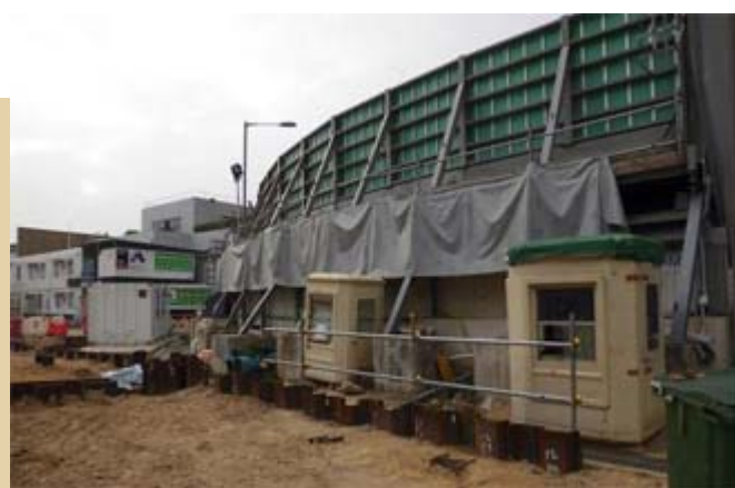
在通道附近設置隔音屏障 2
