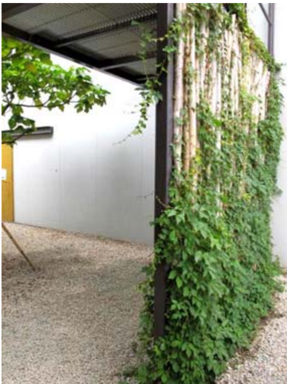
利用循環再用的竹枝，建成 間隔棚架，種滿攀藤植物翠 綠悅目
