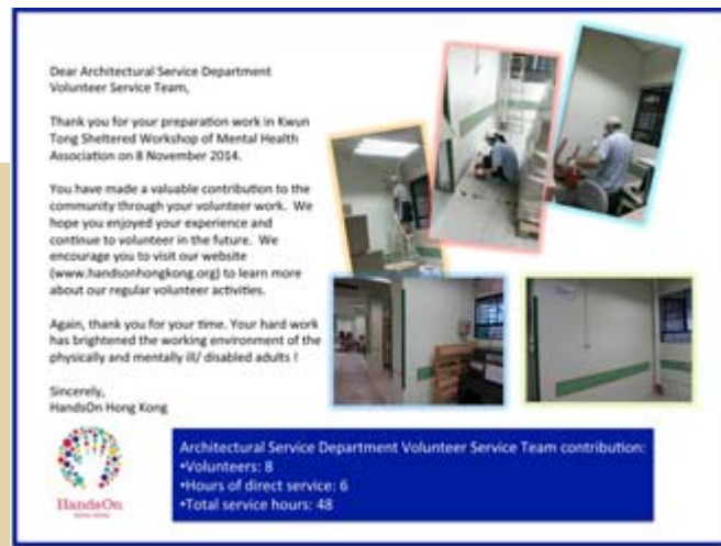
庇護工場裝修工程
