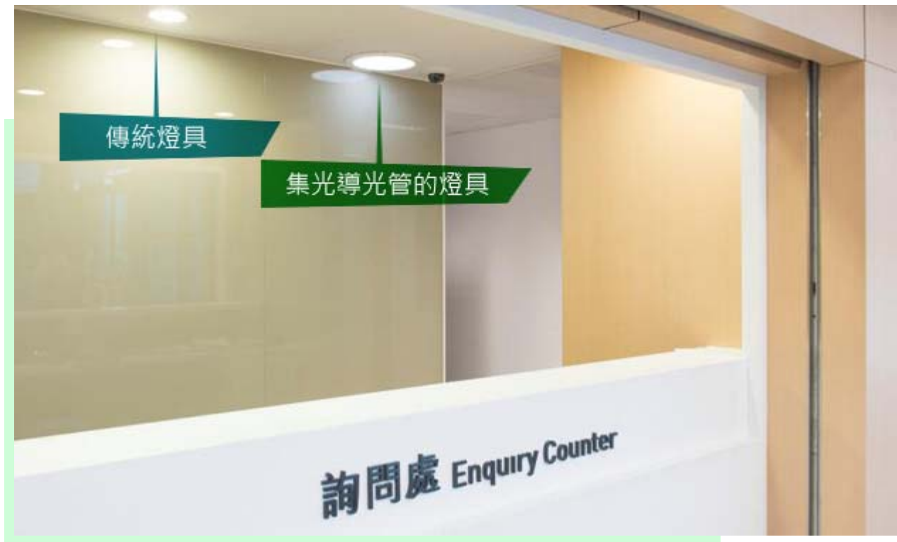
大樓管理辦事處的集光導光管的燈具與傳統燈具的光度相若
