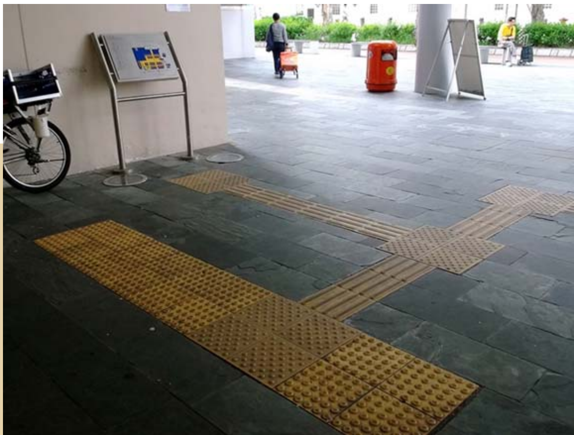
已完竣的無障礙出入設施改善工程
