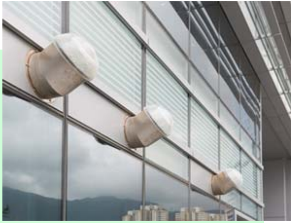
大樓管理辦事處外牆的集光導光管(左)。圖(右)展示集光導光管可橫向傳送陽光。
