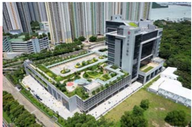
北大嶼山醫院第一期
