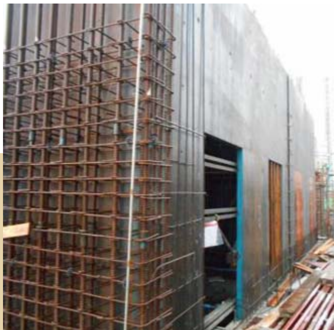
以金屬模板代替傳統木模板 1
