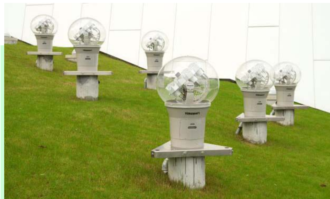
光纖太陽能追蹤導光管利用自動太陽追蹤裝置盡量增加採光
