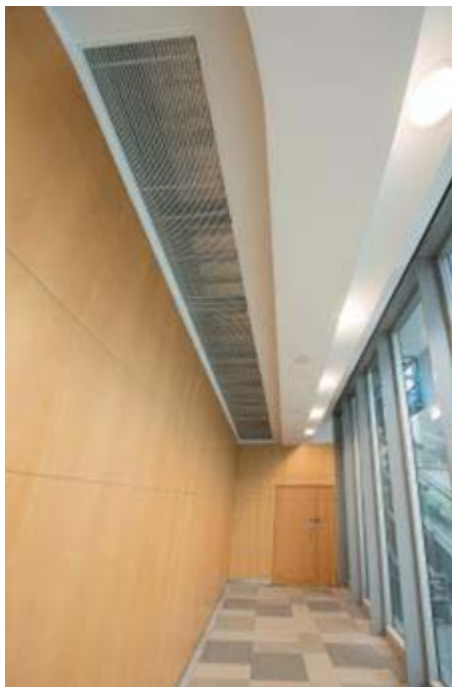
地庫停車場的太陽能煙囪系統
