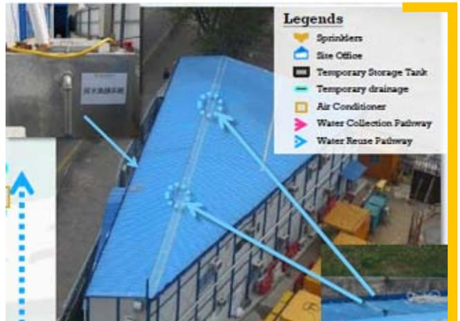
用於冷却工地办公室屋顶的雨水循环再用系统<sup>1</sup>
