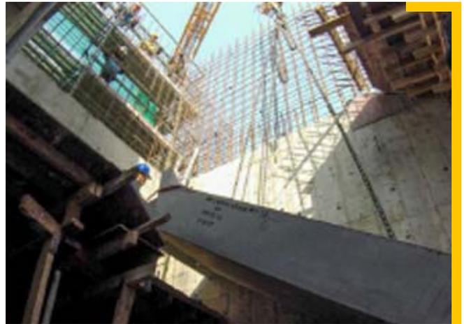
利用金属模板兴建电梯井，及采用预制组件以减少在临时工程上的消耗<sup>1</sup>
