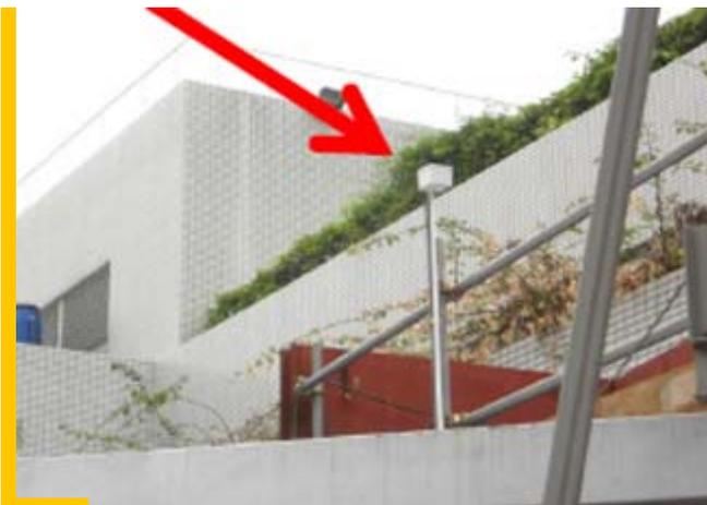
临时围板照明装置的光感应器<sup>3</sup>
