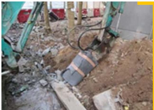
使用备有隔音垫的油压碎石机以减少噪音<sup>2</sup>
