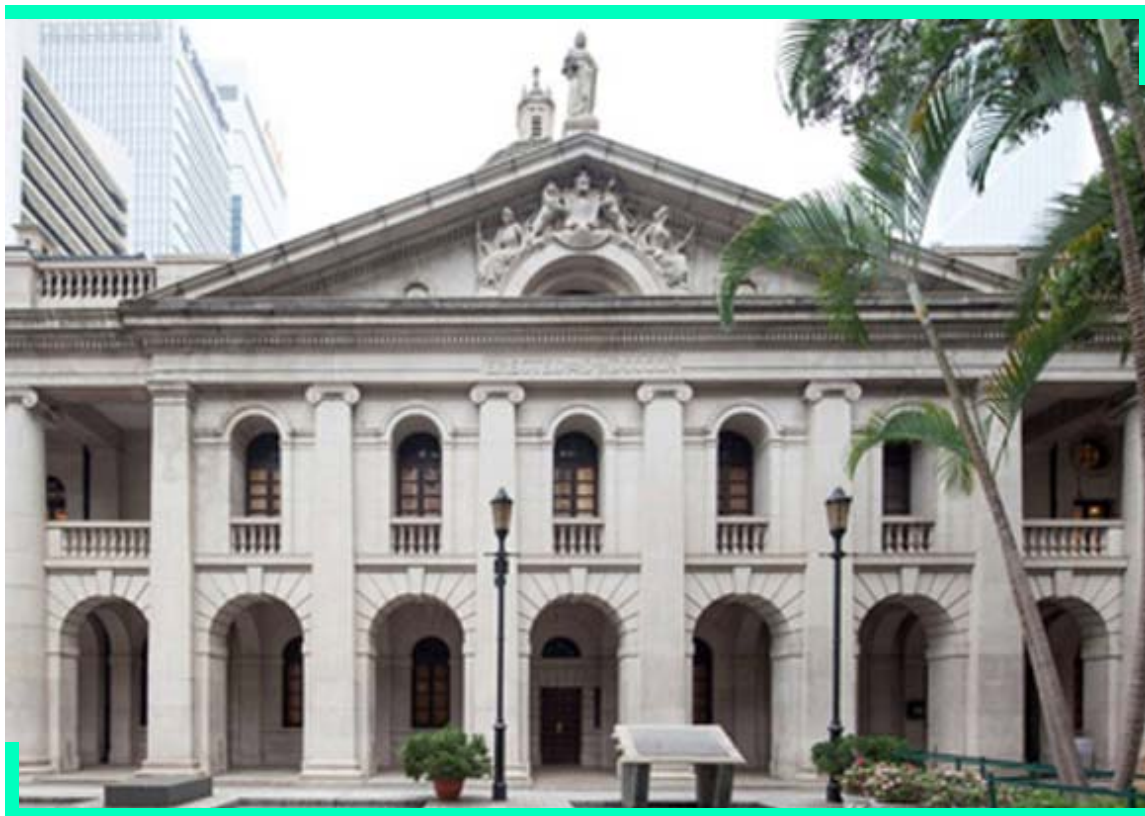
大樓外部進行的維修及修復工程
