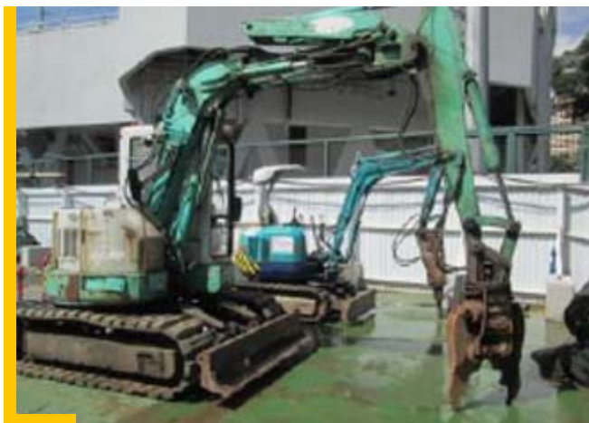
使用備有隔音墊的油壓碎石機以減少噪音 2
