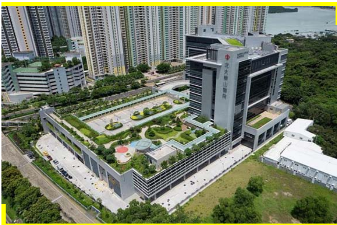
北大嶼山醫院第一期
