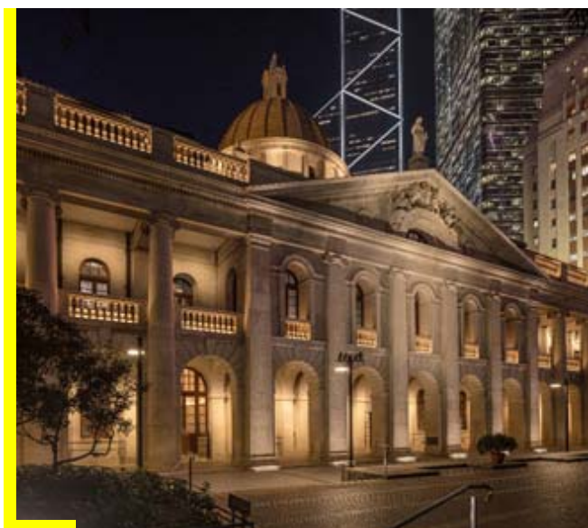
終審法院的復修工程
