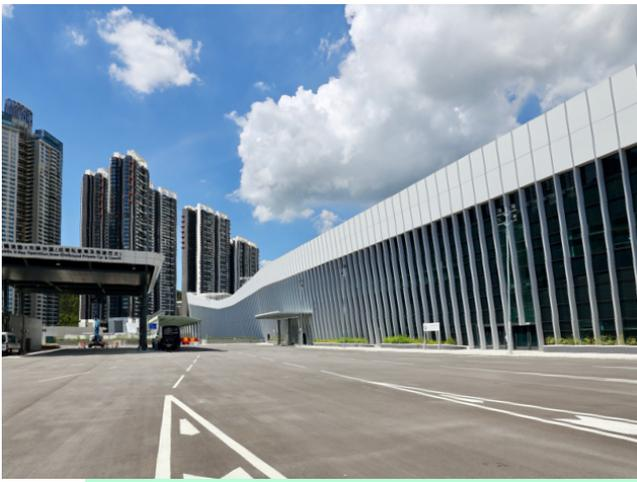
采用低辐射玻璃幕墙和遮阳鳍状,以减低阳光热量的吸收
