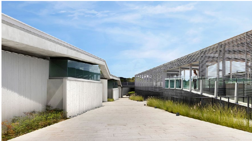
外牆使用以竹條作為模板的玻璃纖維增強水泥板
