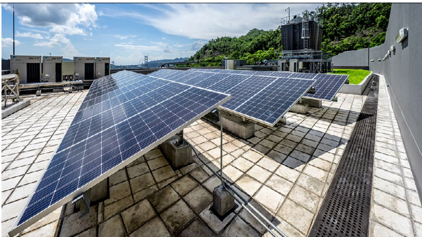
大楼天台安装太阳能板
