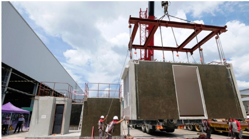
项目利用「组装合成」建筑法，把预制组件运送到施工现场直接进行装嵌
