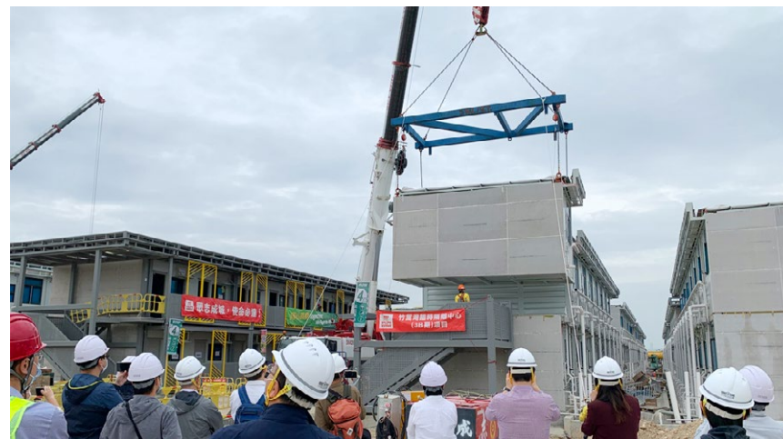
检疫营舍组件由厂房运送到工地进行装嵌
