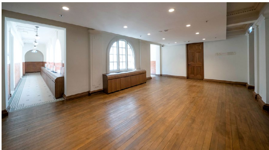
翻新木地板，保持原有建筑特色及减少建筑废物
