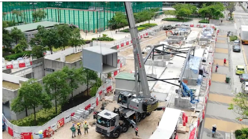
采用「组装合成」建筑法，街市摊档的组件先在厂房预制，然后运往工地装嵌
