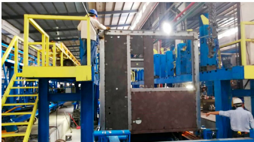
采用「组装合成」建筑法，检疫营舍组件在场外厂房统一生产
