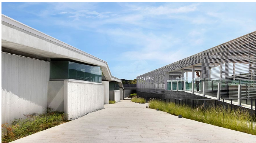
外墙使用以竹条作为模板的玻璃纤维增强水泥板
