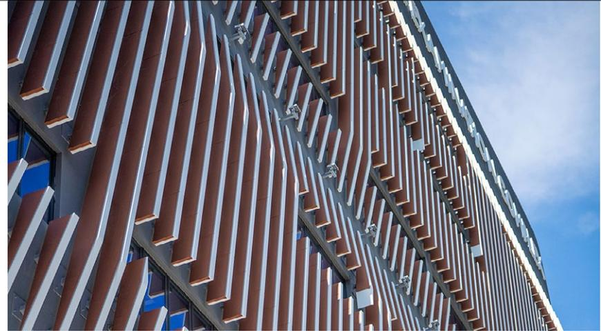
大樓外牆採用特定傾斜十五度角的鰭狀遮擋，以達致最佳遮陽效果
