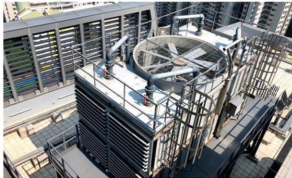
預製組合式冷卻塔系統模組
