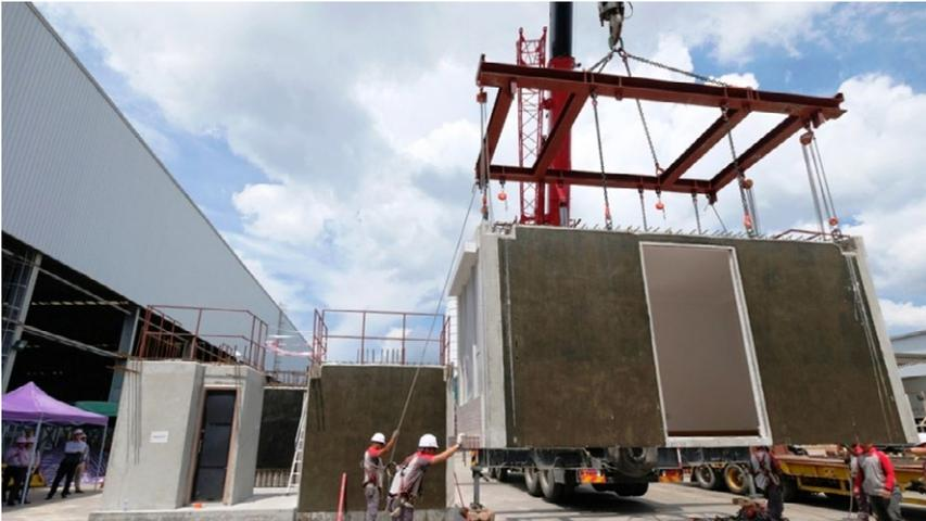
項目利用「組裝合成」建築法，把預製組件運送到施工現場直接進行裝嵌
