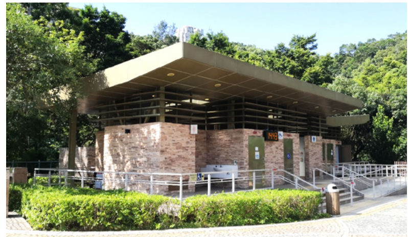
牛池湾公园洗手间翻新工程
