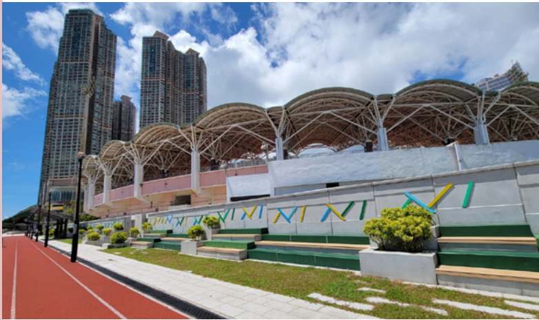
小西湾运动场建造围墙工程
