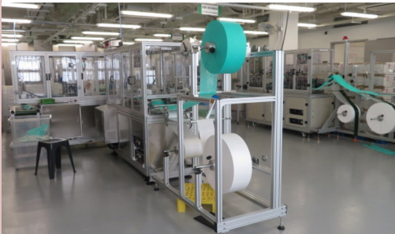
罗湖惩教所口罩工场改建工程
