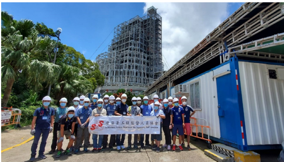
参观大屿山天坛大佛维修工程
