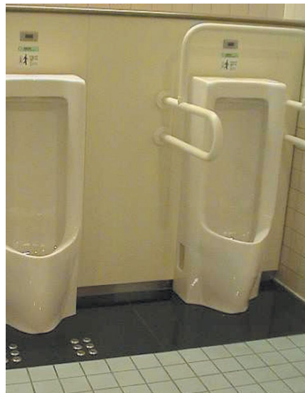
6.11.4a) 能为视觉受损人士提供引导的槽式尿厕
