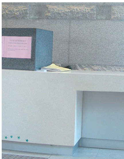
6.15.1a) 为坐轮椅人士预留膝部空间及提供视像显示板的柜台
