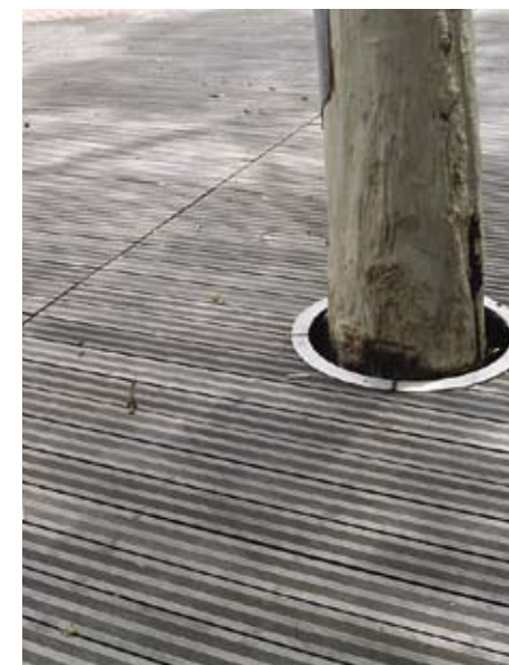
3.1.4.4b 加高地台的去水狹縫與主要行走方向排成直角
