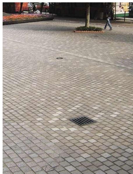
3.1.4.3b 下水道蓋與四周地面齊平，狹縫闊度應少於13毫米
