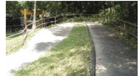
3.1.2.4c 行人徑邊緣出現落差處設有防護欄
