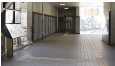
3.2.3.1b 觸覺引路帶從戶外區域導引前往通達指南及其他目的地
