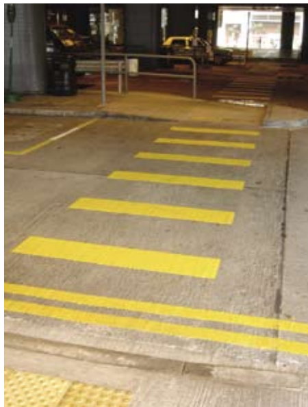
3.2.3.3d 公共運輸交匯處的下斜路緣和觸覺警示帶
