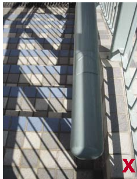
3.2.3.1e 地面圖案繁雜，加上日照影響，會令行人上落樓梯時感到不適，甚至危害安全
