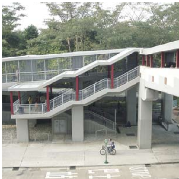
3.2.1a 香港常以行人天橋連接建築物、設施和戶外場地
