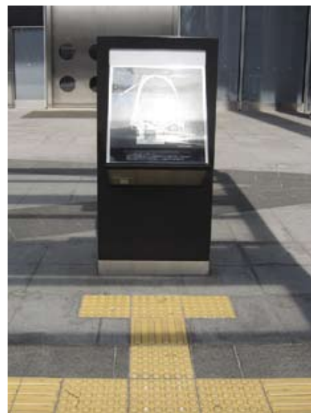
3.5.4.2a 觸覺引路帶通往設於建築物入口附近的傾斜觸覺指南
