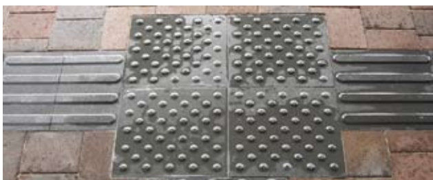
3.6.2.1c 位置磚上的圓點交錯排列，設於觸覺引路帶交界處，以示轉向
