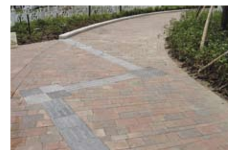
3.6.3.1a 引路帶導引使用者到達路緣，觸覺磚亦能警惕使用者注意感應提示有所轉換
