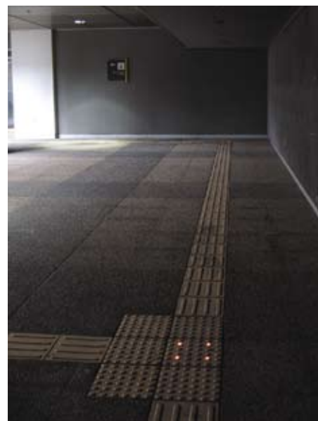
3.6.2.4c 行人隧道鋪設內置小燈的觸覺磚
