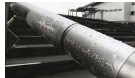
3.6.2.3n 扶手設有點字資訊，方便覓路
