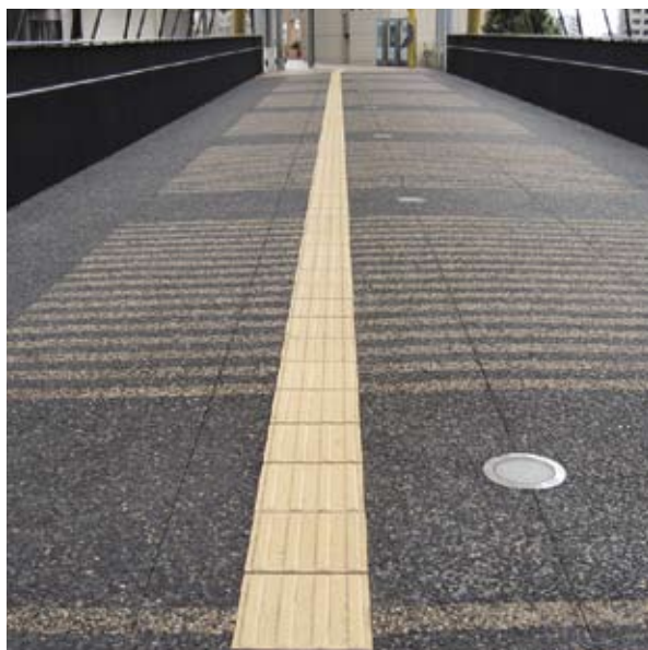
3.6.2.1a 方向指示磚上凸起的長條順行走方向鋪砌
