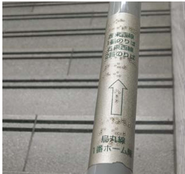
3.6.4.3a 樓梯扶手的點字可幫助確定位置，亦可提供行走方向的資訊
