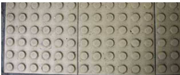
3.6.2.1b 危險警示磚與行走方向成直角，磚面凸起的圓點排列成方形，與磚邊平行
