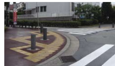
3.6.2.3m 下斜路緣和圍繞防撞柱的觸覺警示帶，提醒行人小心障礙物
