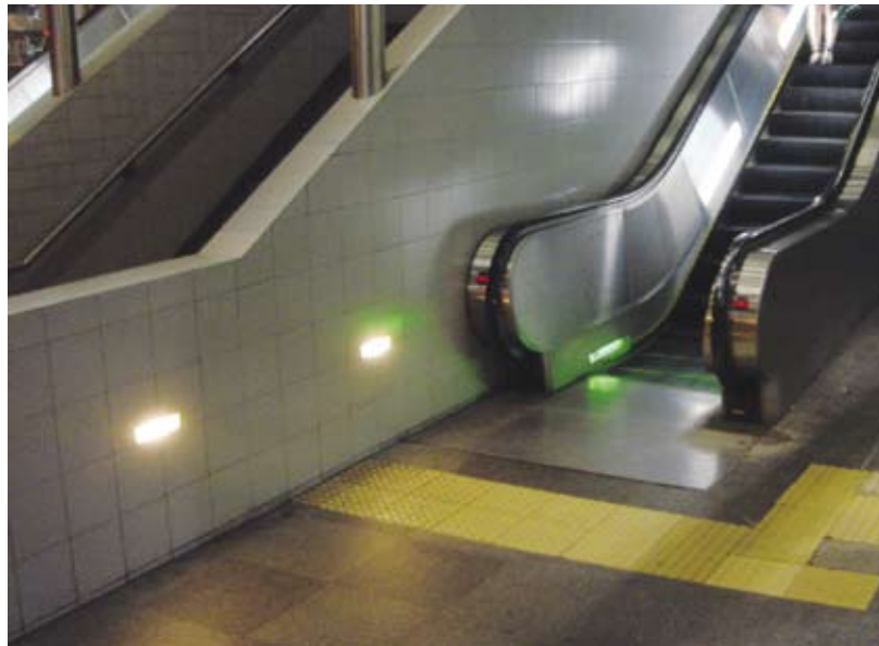
3.8.1.3c 在接近電動扶梯末端的地方安裝掛牆燈
