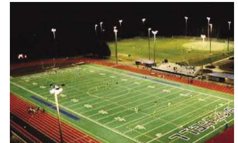
3.8.1.4c 運動場設有全罩式燈罩的照明裝置 (照片由 Soft@Lighting 提供) 1
