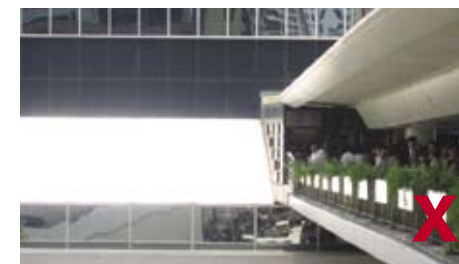
3.8.5.2a 行人天橋旁邊一塊巨型傾斜玻璃，即使換上不反光玻璃，仍然產生眩光
