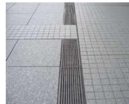
4.1f 渠柵格縫排列方向與行人徑成直角，格縫闊度不得超過13毫米
