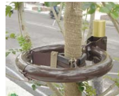
4.3m 路旁樹木的圍樁沒有銳邊或凸出部分
