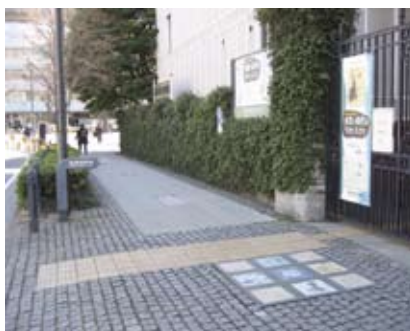
4.6g 以不同鋪路物料識別不同區域，並以橫跨整條行人徑的觸覺警示帶提醒使用者入口的位置
