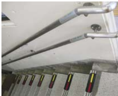
4.6r 雙層扶手上的點字顯示行走方向
