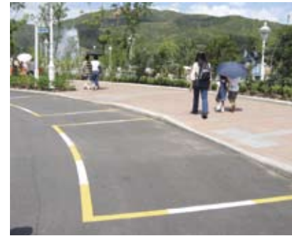
4.6k 上落客地點設有下斜路緣，並有觸覺引路帶通往通達入口
