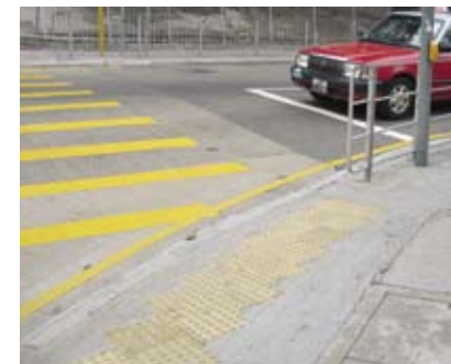
4.6c 行人過路處下斜路緣的觸覺警示帶
