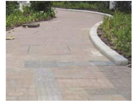
4.6m 可感應面由觸覺引路帶變為路緣石，應充分提醒使用者感應提示的變換
