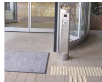
4.6f 觸覺引路帶通往建築物入口設有高低按鈕的自動門
