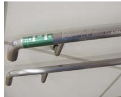
4.6s 上層扶手上的點字標示位置並顯示行走方向
