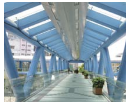
4.8s 行人天橋頂蓋設有天窗，中間加裝一排電燈
