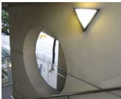
4.8r 在日照不足的暗角加裝電燈，以便補充光線
