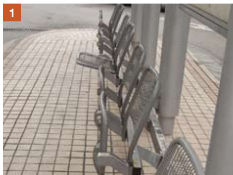
A1.4.1h 狹窄的走廊宜設摺椅，確保有足夠空間讓行人和輪椅通過
