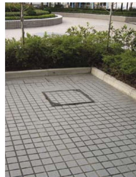
A2.3.6c 沙井蓋與周圍地面齊平。不同地面裝飾的交界亦齊平
