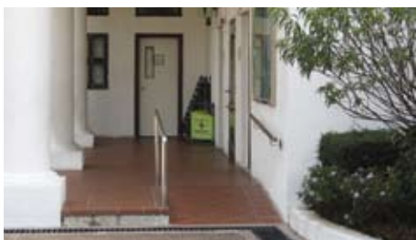
A2.3.3a 設有扶手的斜道方便輪椅出入
