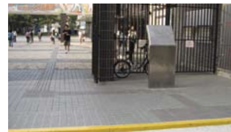
A2.3.4b 場地邊緣鋪設觸覺引路帶，通往觸覺地圖和建築物入口
