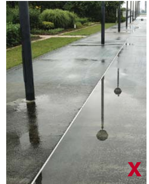
3.1.4.1b 行人道的触觉警示沿途积水，危害途人安全
