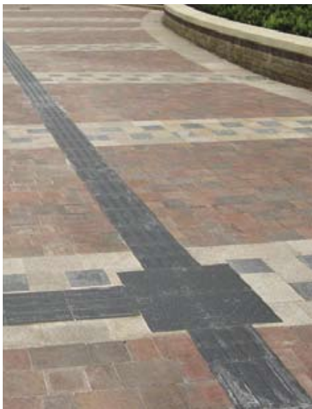
3.1.4.3a 邻近花槽的户外下水道。地面应大致保持平坦
