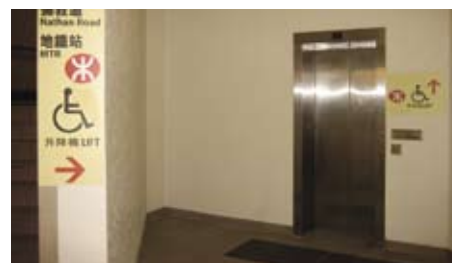
3.1.6.1g 引导前往通达升降机的标志和触觉引路带
