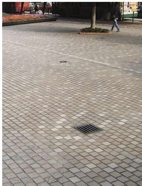
3.1.4.3b 下水道盖与四周地面齐平，狭缝阔度应少于13毫米
