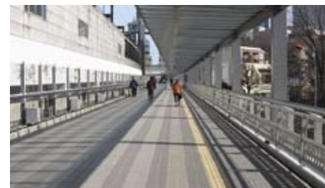
3.1.2.3d 通道有盖，并设有触觉引路带
