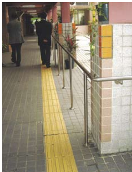
3.1.2.3e 通道沿途设有触觉引路带连扶手
