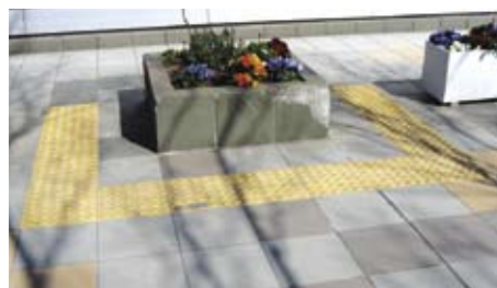
3.1.2.4a 通道沿途的花槽周围有触觉警示带
