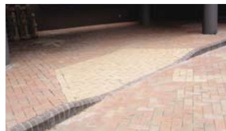
3.1.6.1f 下斜路缘与毗连行人路的颜色对比鲜明
