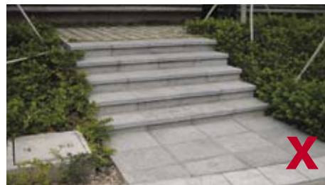
3.1.6.1b 楼梯及梯级应有足够扶手和颜色对比鲜明的级面凸缘
