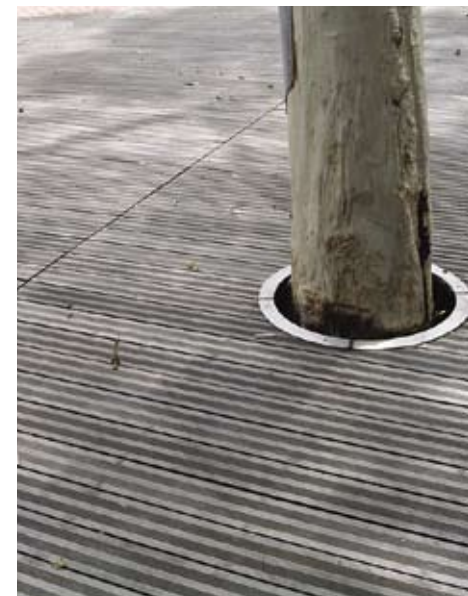
3.1.4.4b 加高地台的去水狭缝与主要行走方向排成直角
