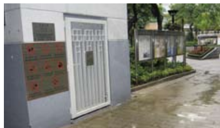
3.1.2.4b 公园入口大闸嵌入墙内，令通道畅通无阻
