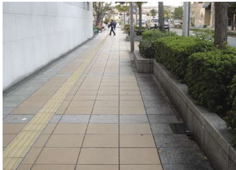
3.1.1b 通道畅通无阻，并设有触觉引路带
