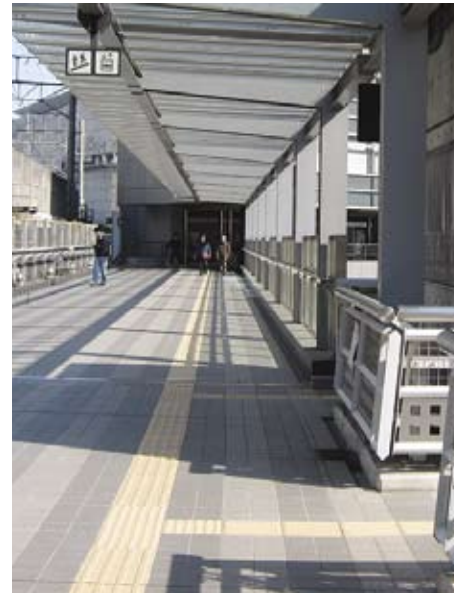
3.1.4.1a 排水渠设于行人道边缘，与触觉引路带保持距离
