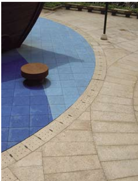
3.1.4.2a 排水渠盖与毗连地面齐平，狭缝少于13毫米阔
