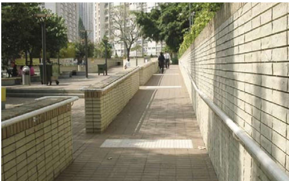
3.1.6.1e 斜道两端设有触觉警示带，两旁设有扶手，路面与两侧墙壁的颜色对比鲜明
