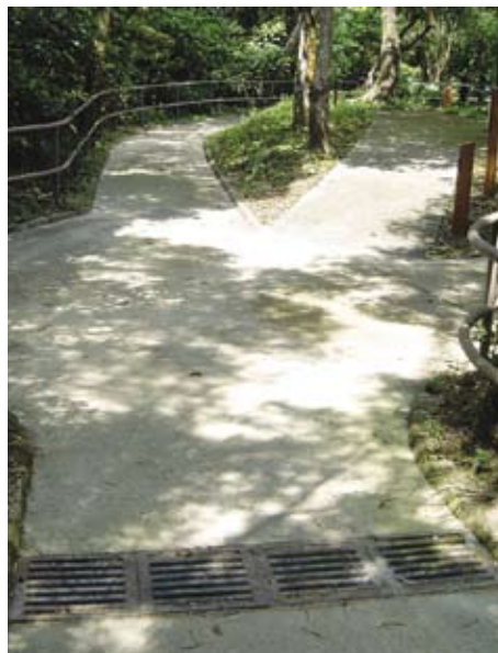
3.1.4.2b 长形栅孔与行走方向排成直角
