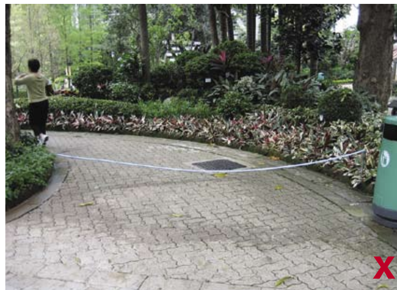
3.10.1b 维修工程进行期间，行人径应该改道
