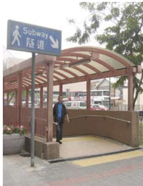
3.2.3.2c 以标志和触觉警示带指示行人隧道入口的位置
