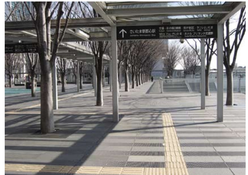
3.2.3.4a 休憩用地设有触觉引路带通往各幢建筑物
