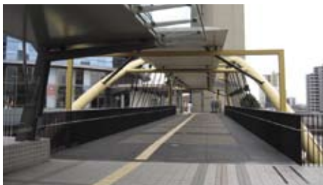
3.2.3.1a 触觉引路带从行人道伸延至连接天桥
