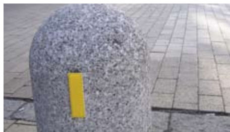
3.4.1.3c 镶嵌反射面警示的防撞柱
