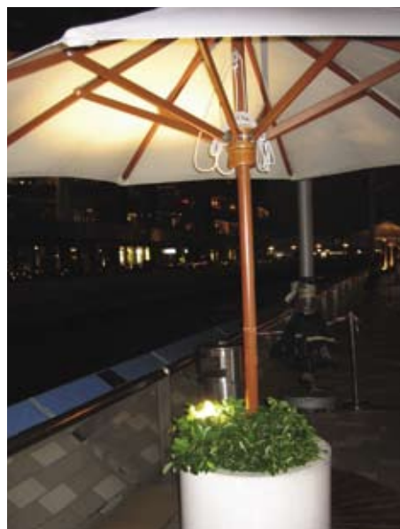
3.4.4.2c 仰射式照明设备藏于伞下
