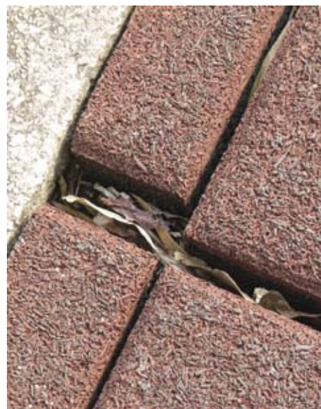
3.4.2.4r 除了检查儿童游乐场的游乐设备外，亦应检查其他配套设施及装置，例如地面物料的损耗程度
