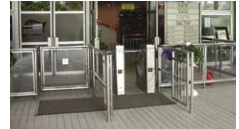
3.4.1.2h 转闸旁边的通达闸门
