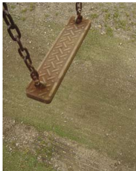
3.4.2.4r 除了检查儿童游乐场的游乐设备外，亦应检查其他配套设施及装置，例如地面物料的损耗程度
