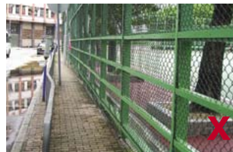
3.4.1.1d 妥善支承的铁网围栏(上图)和突出至狭窄行人径的变形铁网围栏(下图)
