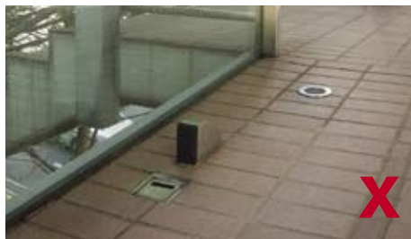
3.4.1.2d 避免闸门门顶凸出地面
