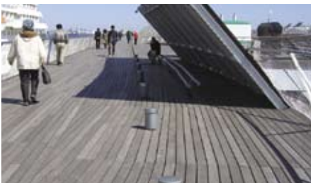
3.4.1.1c 斜墙前的护栏防止途人走近，并提供遮荫座椅，方便歇息。
