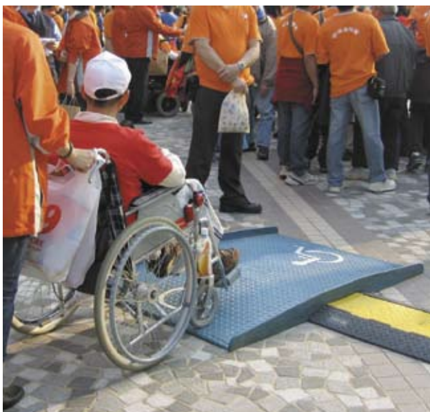
3.4.6.1c 临时通达斜道设于已遮盖的地面电线上
