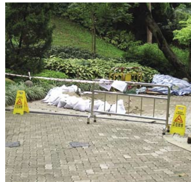
3.4.6.1e 维修区以护栏围封，并设警告标志
