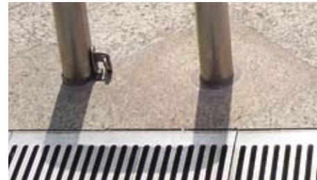
3.4.1.2f 锁定装置令护栏柱稳固
