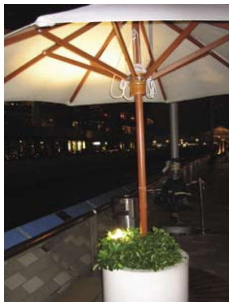
3.4.4.2c 仰射式照明设备藏于伞下
