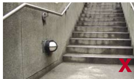
3.4.1.5c 避免使用凸出的墙灯
