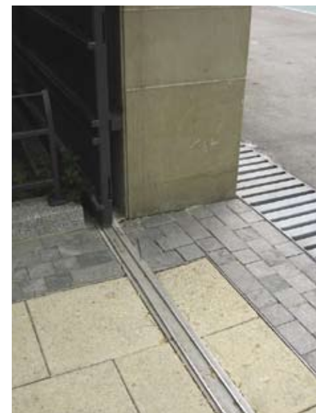
3.4.1.2b 高度少于10毫米的路轨
