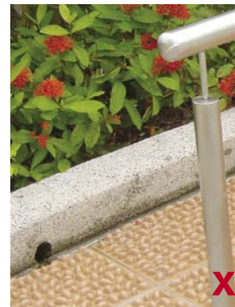
3.4.3.2c 花圃等排水孔出口应远离户外运动场地的地面
