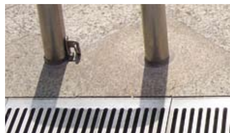
3.4.1.2f 锁定装置令护栏柱稳固
