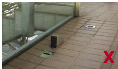
3.4.1.2d 避免闸门门顶凸出地面
