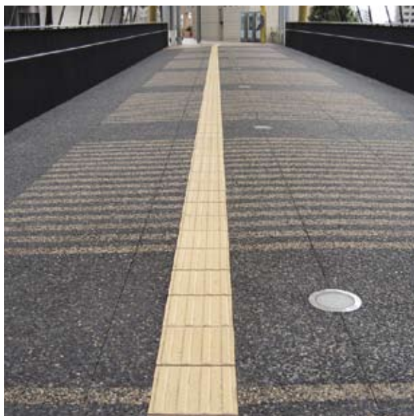
3.6.2.1a 方向指示砖上凸起的长条顺行走方向铺砌
