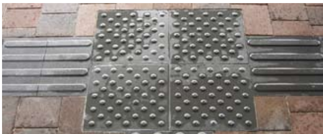
3.6.2.1c 位置砖上的圆点交错排列，设于触觉引路带交界处，以示转向
