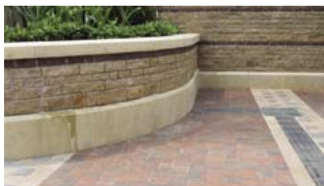
3.6.3.1b 以触觉引路带导引使用者转换到花槽围墙；如感应提示有改变，应尽快提醒使用者
