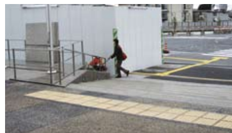
3.6.2.3a 行人径平面高度改变之处的触觉警示带，横跨行人径
