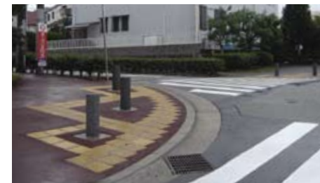
3.6.2.3m 下斜路缘和围绕防撞柱的触觉警示带，提醒行人小心障碍物
