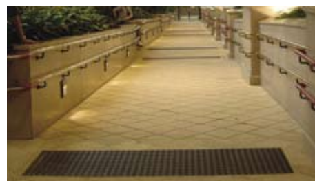
3.6.2.4a 触觉砖与四周地面的颜色及质感明显不同
