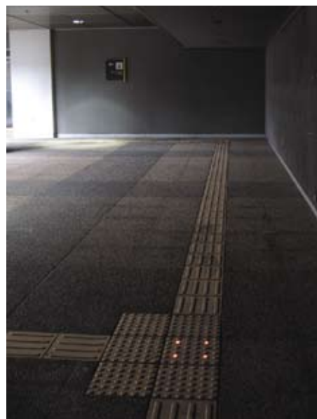
3.6.2.4c 行人隧道铺设内置小灯的触觉砖
