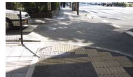
3.6.2.3e 行人过路处下斜路缘的触觉警示带
