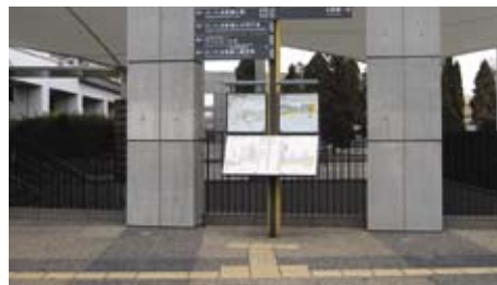
3.6.2.3j 触觉引路带通往设施入口附近的触觉指南
