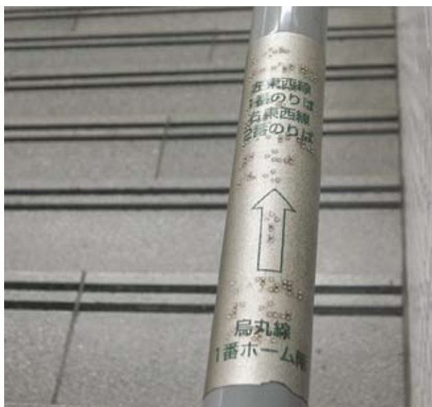
3.6.4.3a 楼梯扶手的点字可帮助确定位置，亦可提供行走方向的资讯
