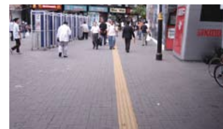
3.6.2.3f 行人径的触觉警示带
