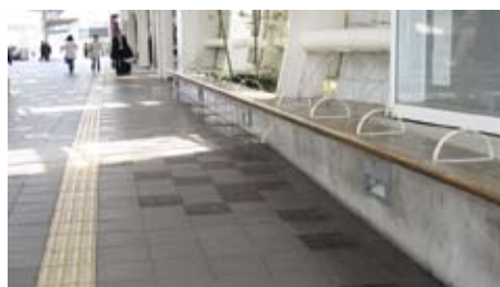
3.6.2.2b 触觉引路带远离建筑物边缘及障碍物
