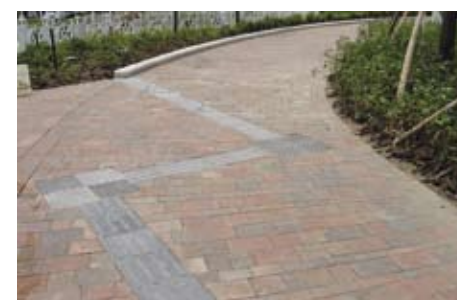
3.6.3.1a 引路带引导使用者到达路缘，触觉砖亦能警惕使用者注意感应提示有所转换
