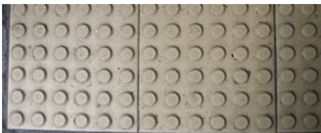
3.6.2.1b 危险警示砖与行走方向成直角，砖面凸起的圆点排列成方形，与砖边平行
