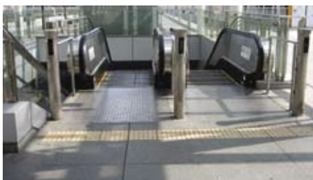
3.6.2.3h 横跨电动扶梯左右两边的触觉警示带
