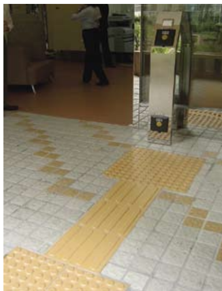
3.6.3.4a 由触觉引路带通往自动门，可操作触觉开门设备
