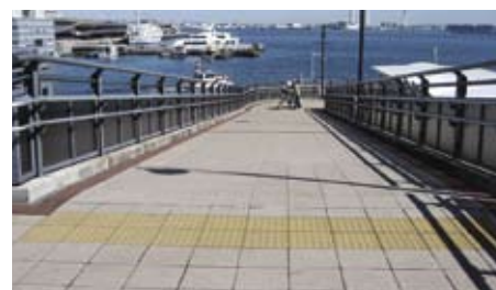
3.6.2.3d 斜道的触觉警示带
