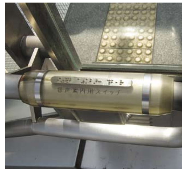
3.6.4.3b 用手触及装有感应器的扶手时，便会提供触觉（点字）及声频（录音）的资讯
