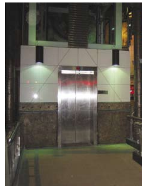
3.8.1.3d 除行人径的照明装置外，在通往行人天桥的升降机入口加设挂墙灯
