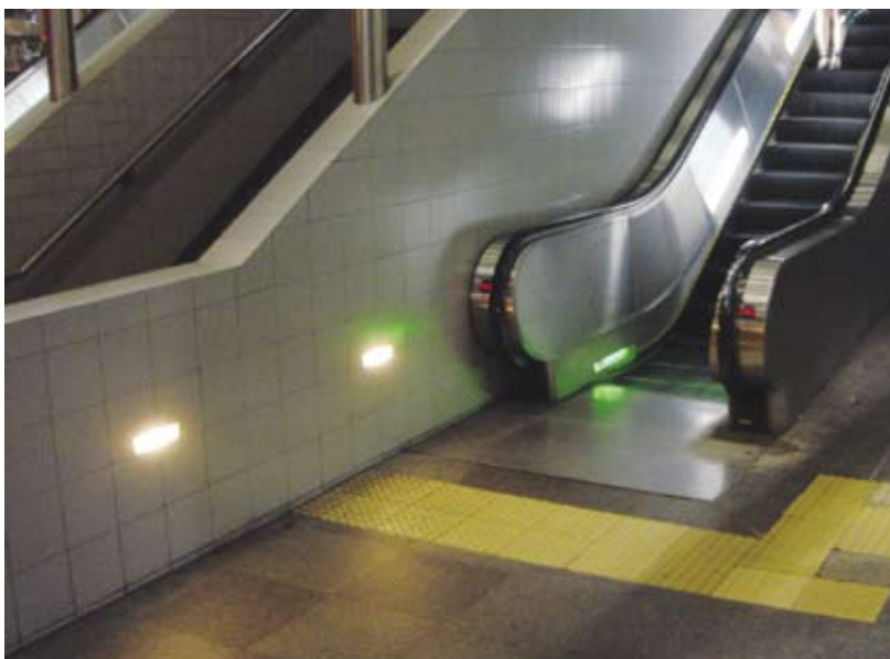
3.8.1.3c 在接近电动扶梯末端的地方安装挂墙灯
