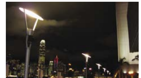
3.8.2.2d 经改善后远离尖沙咀海堤边缘安装的间接照射灯柱
