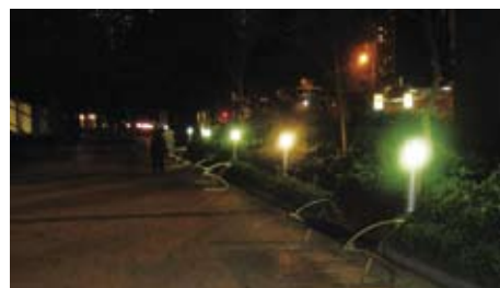
3.8.3.2a 长椅后花槽内的矮灯可照亮行人面部，但行人径路面仍然阴暗
