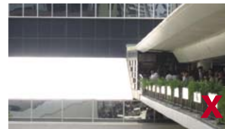
3.8.5.2a 行人天桥旁边一块巨型倾斜玻璃，即使换上不反光玻璃，仍然产生眩光
