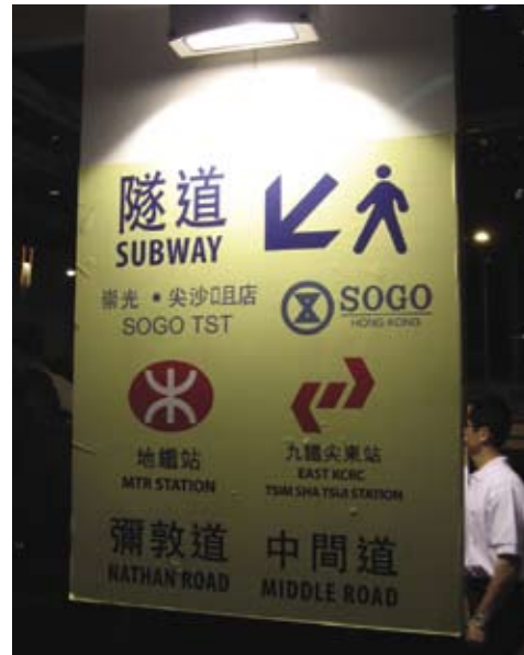
3.8.1.2a 照射标志的挂墙灯光线强烈，令标志多处出现光影
