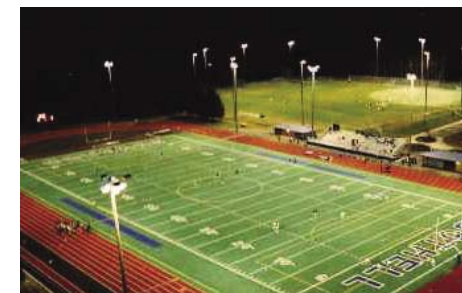
3.8.1.4c 运动场设有全罩式灯罩的照明装置 (照片由Soft@Lighting提供) 1
