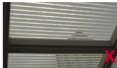
3.8.5.4a 遮挡阳光的天窗不宜采用与行走方向成直角的横纹式样
