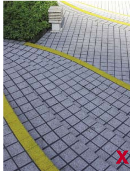
3.9.2.1g 没有缓冲区而级面凸缘又不显眼的梯级易生危险
