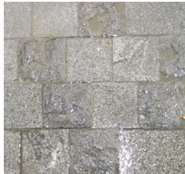
3.9.3.1c 考虑铺地物料表面的粗糙程度时，必须在良好防滑效果与预防绊脚之间取得平衡
