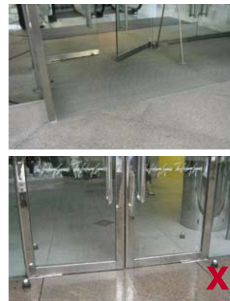
3.9.2.1d 从户外通往室内的入口铺设地毯，有助预防行人滑倒或绊倒
