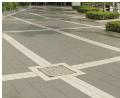
4.1h 排水口与地面大致平坦，渠盖与周围铺地终饰齐平
