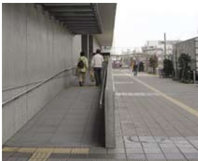
4.1a 畅通无阻的通道设有触觉引路带，颜色与周围铺地终饰对比鲜明
