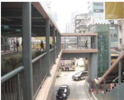
4.2j 畅通易达的升降机方便公众在行人天桥接驳点上落
