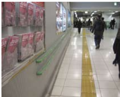
4.2a 行人隧道接驳区的触觉引路带和双层扶手方便出入
