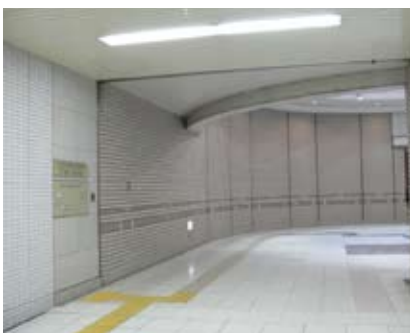
4.2n 触觉引路带通往行人隧道交界处的触觉指南
