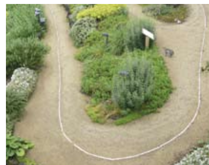
4.3q 园景区内蜿蜒的通达斜道铺设触觉提示
