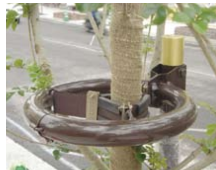
4.3m 路旁树木的围桩没有锐边或凸出部分
