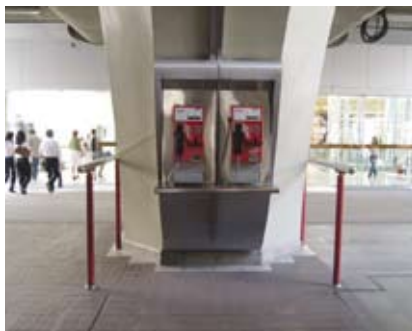
4.4u 设于楼梯下面的电话，两旁设有护栏
