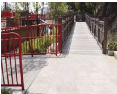
4.4j 斜道铺设触觉警示带，两旁的扶手高度适中
