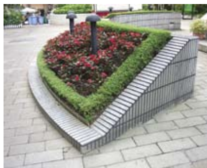
4.4p 斜置花槽提供较好的视觉效果，游人不论高矮，都能近观花草
