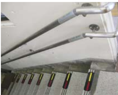
4.6r 双层扶手上的点字显示行走方向
