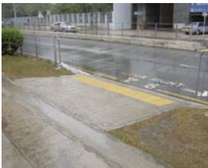
4.6j 行人过路处下斜路缘的触觉警示带
