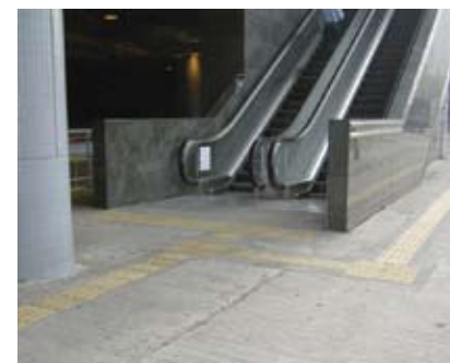
4.6i 触觉引路带通往交通设施和连接其他目的地的设施
