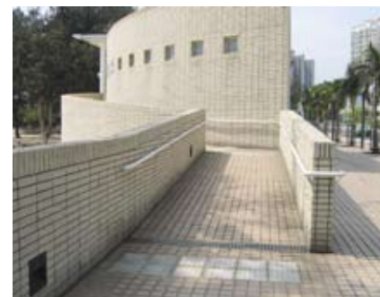
4.7mm 斜道地面的终饰物料与墙身不同，在视觉上营造对比效果
