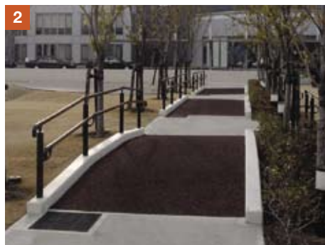
A1.3.1j 健身斜道铺以橡胶物料，可在行人跌倒时发挥保护作用，其硬度亦能让轮椅经过
