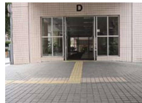
A1.3.1f 视域4 D座入口的斜道
