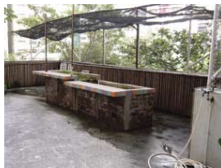
A1.4.1e 视域3 院友使用的园艺工作台，周边宜扩阔空间方便轮椅出入
