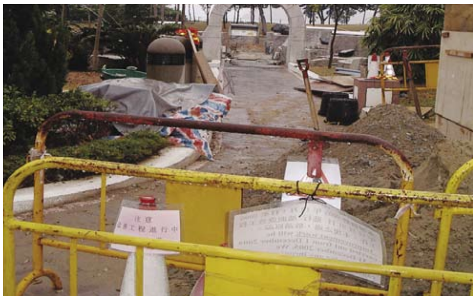
A2.12.1a 维修期间以临时栏障围封
