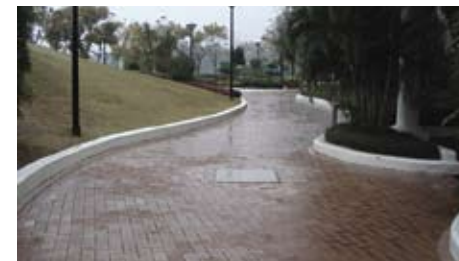
A2.3.2a 行人径沿途路面平坦，兼有路缘区分通道
