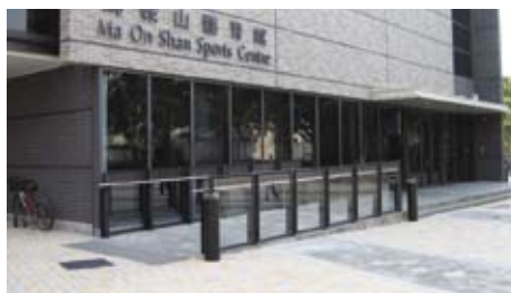
A2.3.4c 通向体育馆的斜道两端设有触觉警示带
