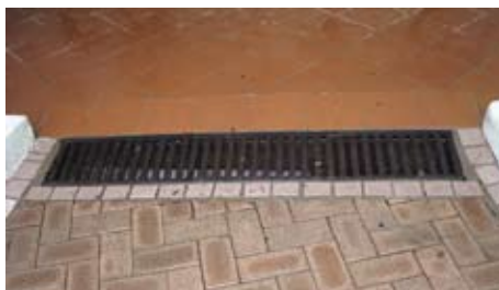
A2.3.6b 渠盖阔逾13毫米的格缝或会卡着轮椅或手杖
