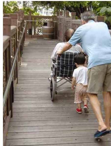
3.4.2.6b Access ramp
